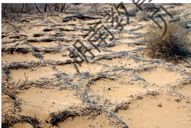
图 2-29 包兰铁路沙坡头段的草方格
