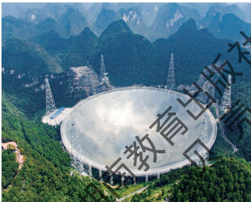
2016年9月，500米口径球面射电望远镜在贵州平塘的喀斯特洼坑中落成启用。它拥有30个标准足球场大的接收面积，是目前世界最大单口径、最为灵敏的射电望远镜，被誉为“中国天眼”。该望远镜成功运行后，其超强的灵敏度显著提高了人类探索宇宙的能力。
