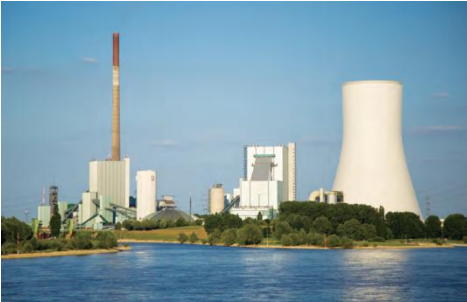
图 2-29 鲁尔区改造后的发电厂
