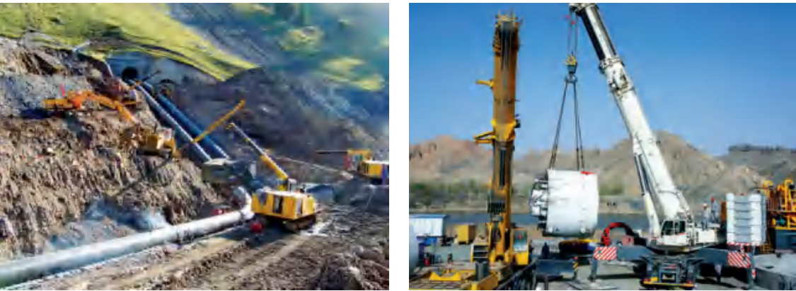
图 3-11 “西气东输”工程建设现场
