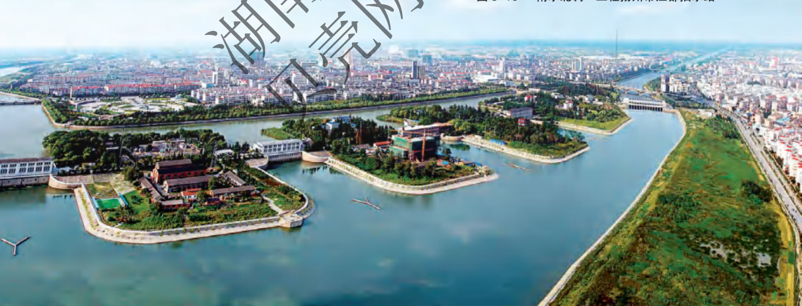
图 3-16 “南水北调”工程扬州市江都抽水站
