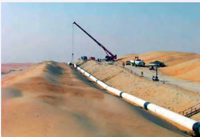
图 2-11 阿联酋人工淡化海水储备库输水管道
